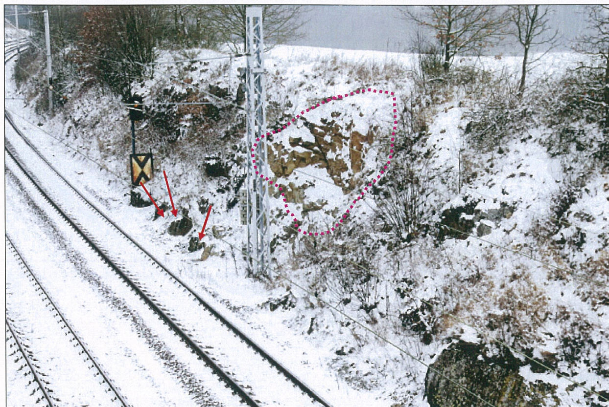
Foto – 22 Pohled z mostu na pravou stranu svahu k žst. Pačejov s rozvolněnými bloky (vyznačeno jako karmínová oblast) v horní partii skalní stěny. Sněhová pokrývka znemožňuje další hodnocení plochy svahu. Šipky ukazují na již vypadlé fragmenty.
