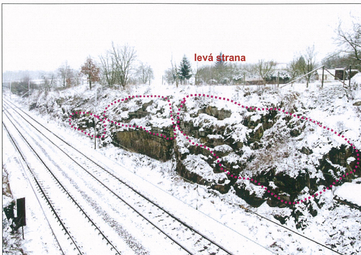
Foto – 3 Pohled z mostu směrem k Horažďovicím na pravý svah. Na snímku jsou karmínově vyznačené oblasti s uvolněnými bloky žuly, mající tendenci k vyklápění ze svahu.
