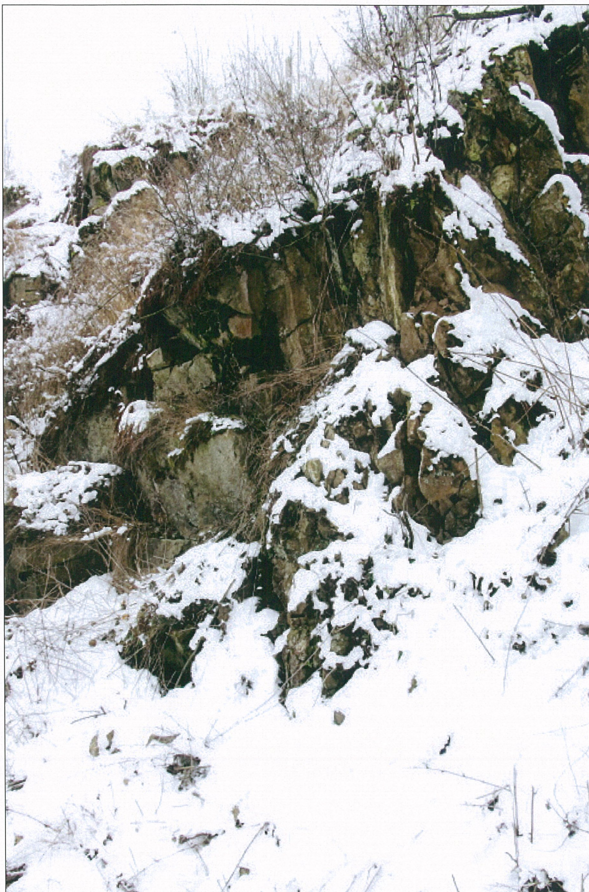
Foto – 12 Výřez z horního snímku (levá strana). Je vidět labilní stav bloků.
