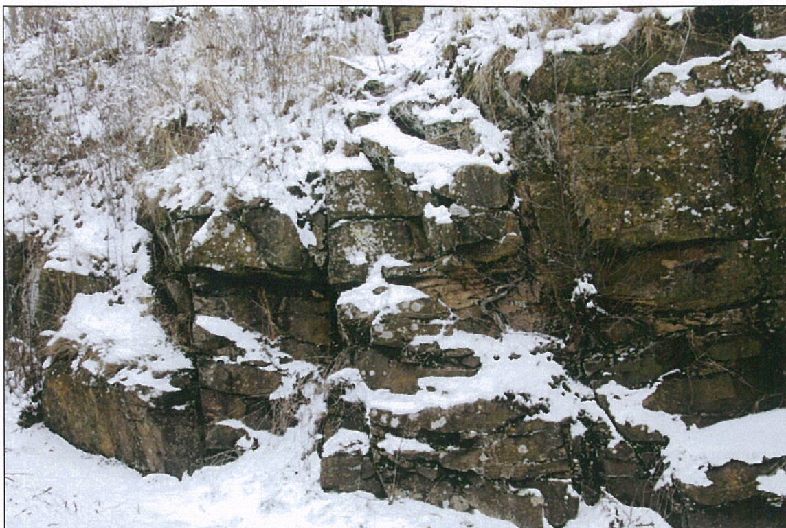
Foto – 10 Pohled na levé straně na zcela rozvolněnou spodní partii svahu.
