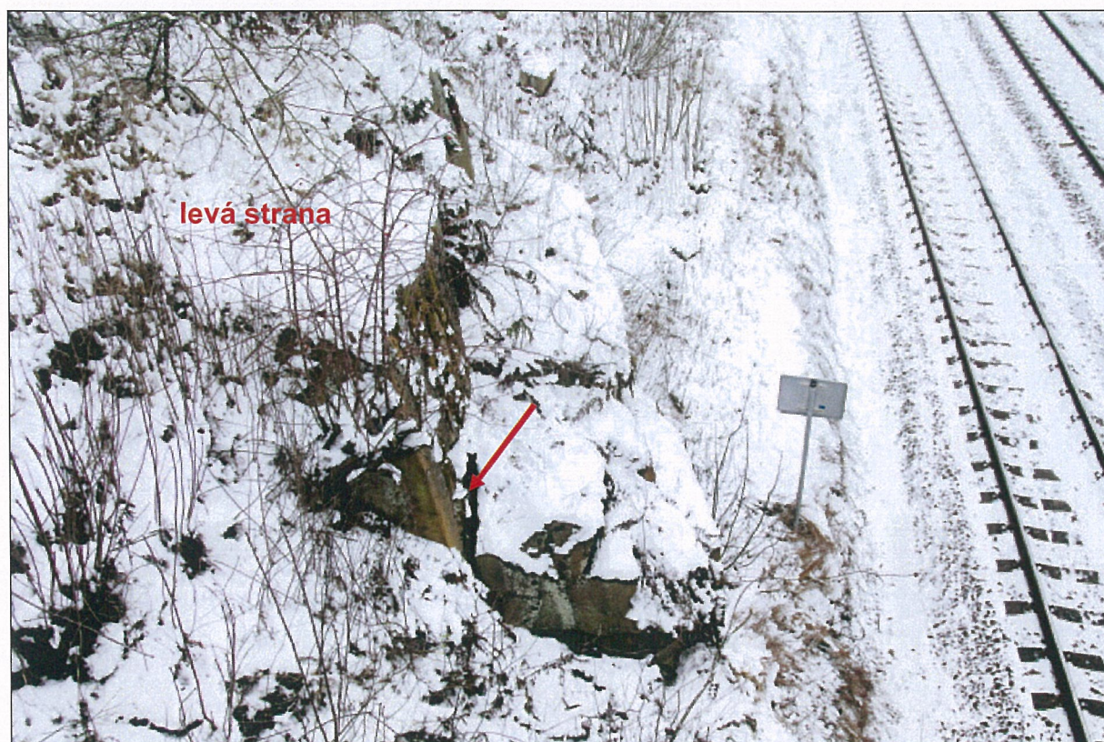
Foto – 20 Pohled z mostu na levou stranu svahu k žst. Pačejov s rozvolněným blokem. Šipka ukazuje na otevřenou puklinu šířky min. 5 cm. Jinak je vyznačeno ještě na foto 16 a 17.
