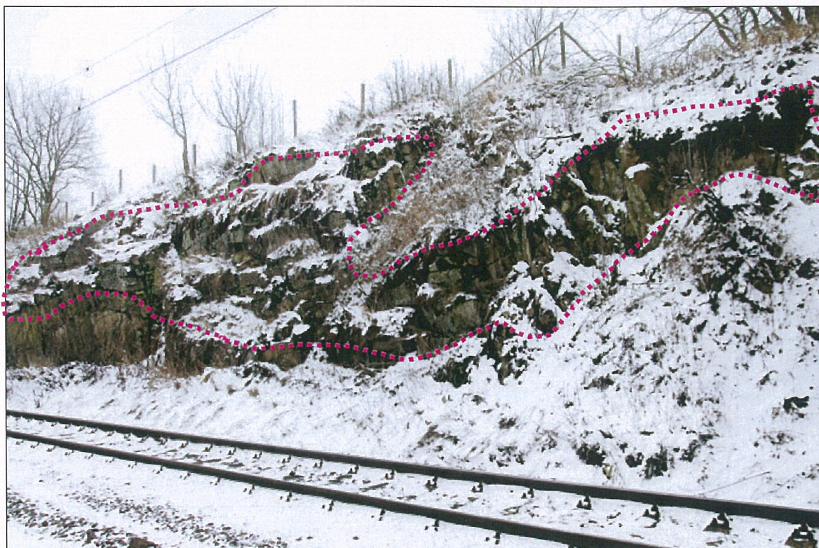
Foto – 11 Pohled na levou stranu zcela rozvolněné masivu před mostem od Horažďovic. Karmínově vyznačené oblasti omezují problémová místa. Vzdálenost od krajního kolejového pasu je cca 1,5 m!
