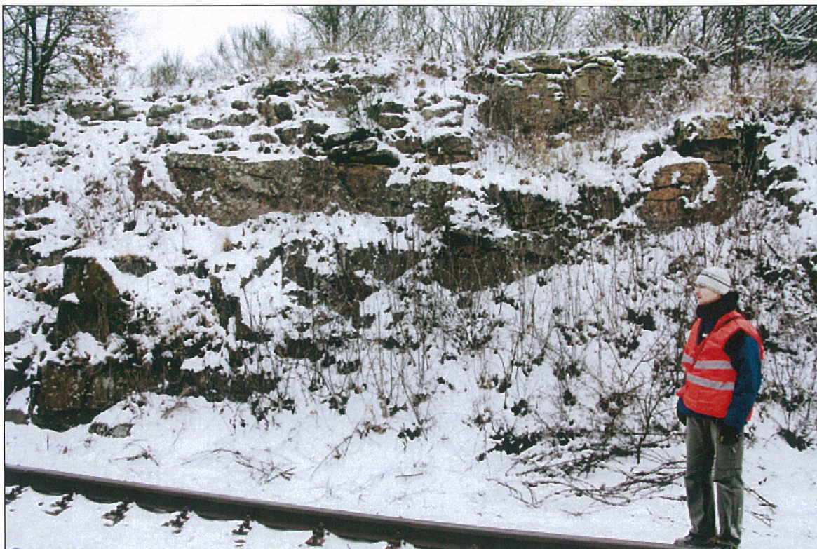
Foto – 7 Pohled na pravou stranu s rozvolněnými bloky, zejména v horní polovině.
