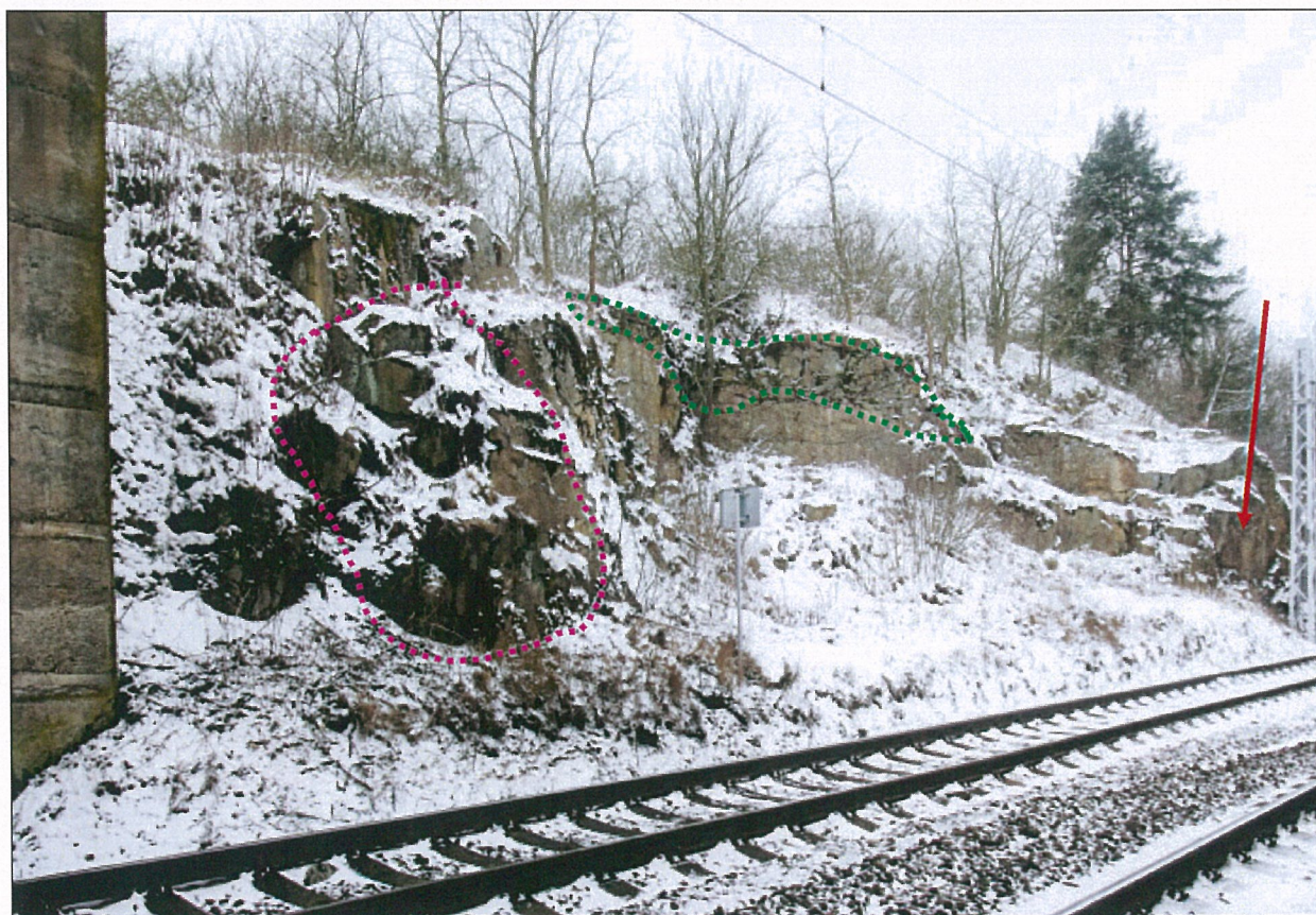
Foto – 16 Pohled na levou stranu od mostu k žst. Pačejov. Karmínově vymezená oblast ukazuje na vyklápějící se bloky! Červená šipka ukazuje na skalní stěnu u TS převalskou ke koleji. Zelená oblast vymezuje totálně rozvolněnou hranu skalní stěny.
