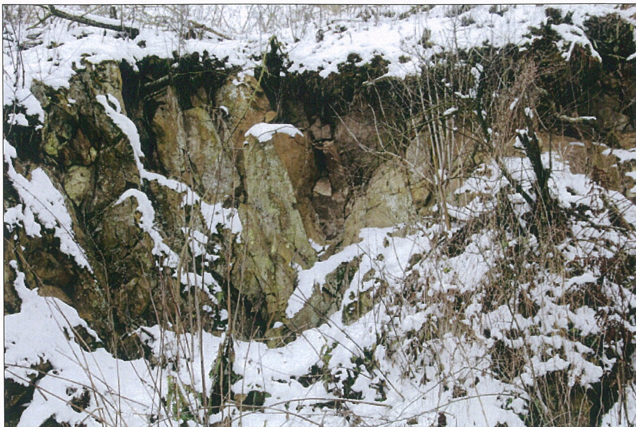
Foto – 13 Detail rozvolněné partii svahu v horní části na levé straně před mostem od Horažďovic.
