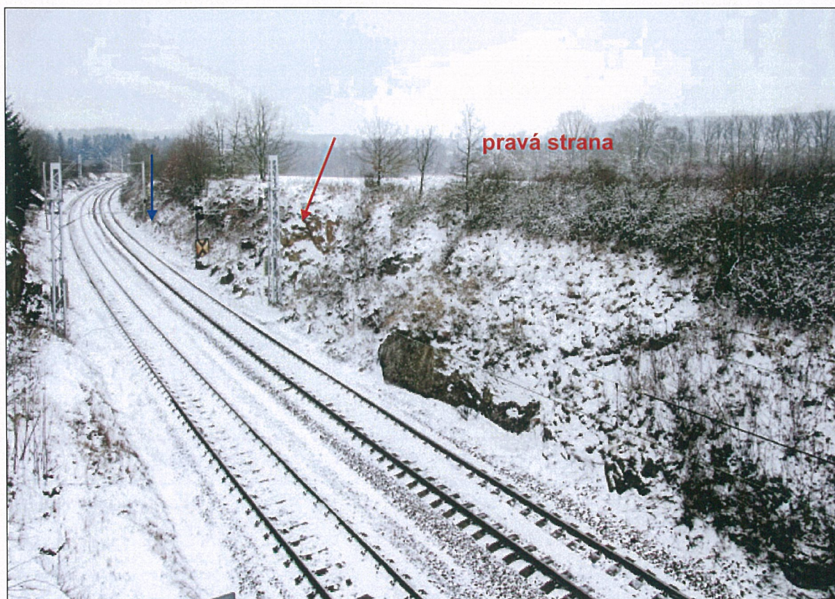
Foto – 2 Pohled z mostu směrem k Plzni na pravý svah. Červená šipka ukazuje na uvolněný blok. Modrá šipka ukazuje na konec potřebného zajištění svahu.
