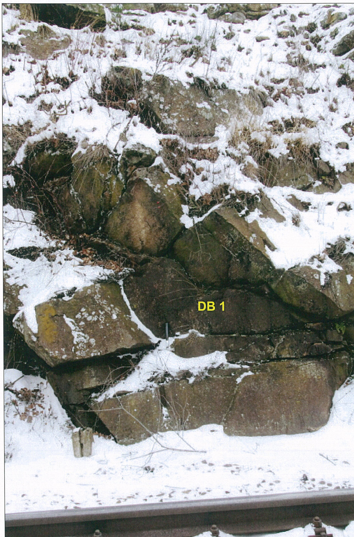
Foto – 9 Pohled na pravé straně na místo dokumentačního bodu DB 1 v km 299,600. Jsou dobře patrné zcela rozvolněné a převísle bloky horniny. Pukliny jsou v lici převážně otevřené.
