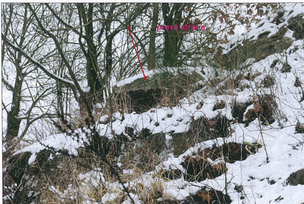
Foto – 8 Pohled na pravé straně v km cca 299,600 jak ukazuje šipka. Kořeny stromů působí destruktivně. Rozevírají pukliny.
