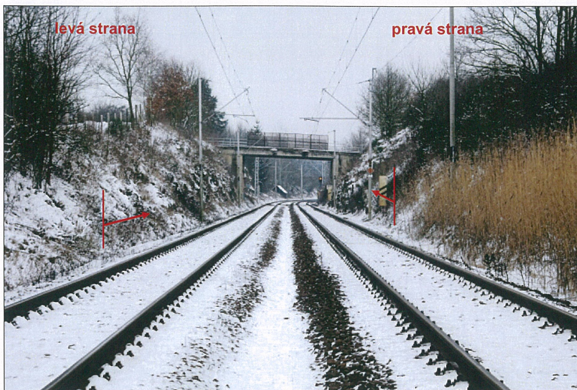
Foto – 5 Pohled do zářezu směrem k Pačejovu. Šipky ukazují na počátek nutného zajištění obou svahů směrem k mostu.
