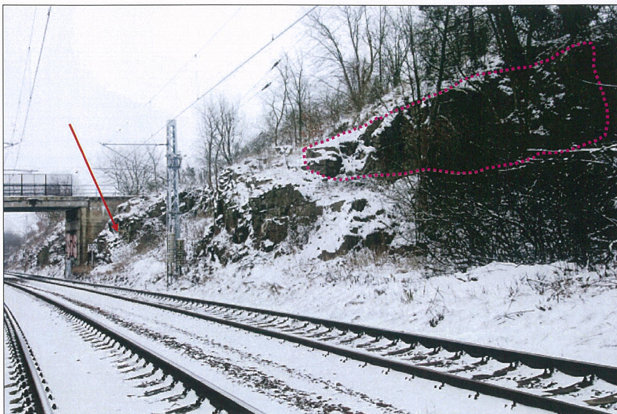
Foto – 17 Pohled k Horažďovicím na levý svah. Červená šipka ukazuje na rozvolněný blok viz foto – 4. Karmínově omezená oblast ukazuje na rozvolněný svah.
