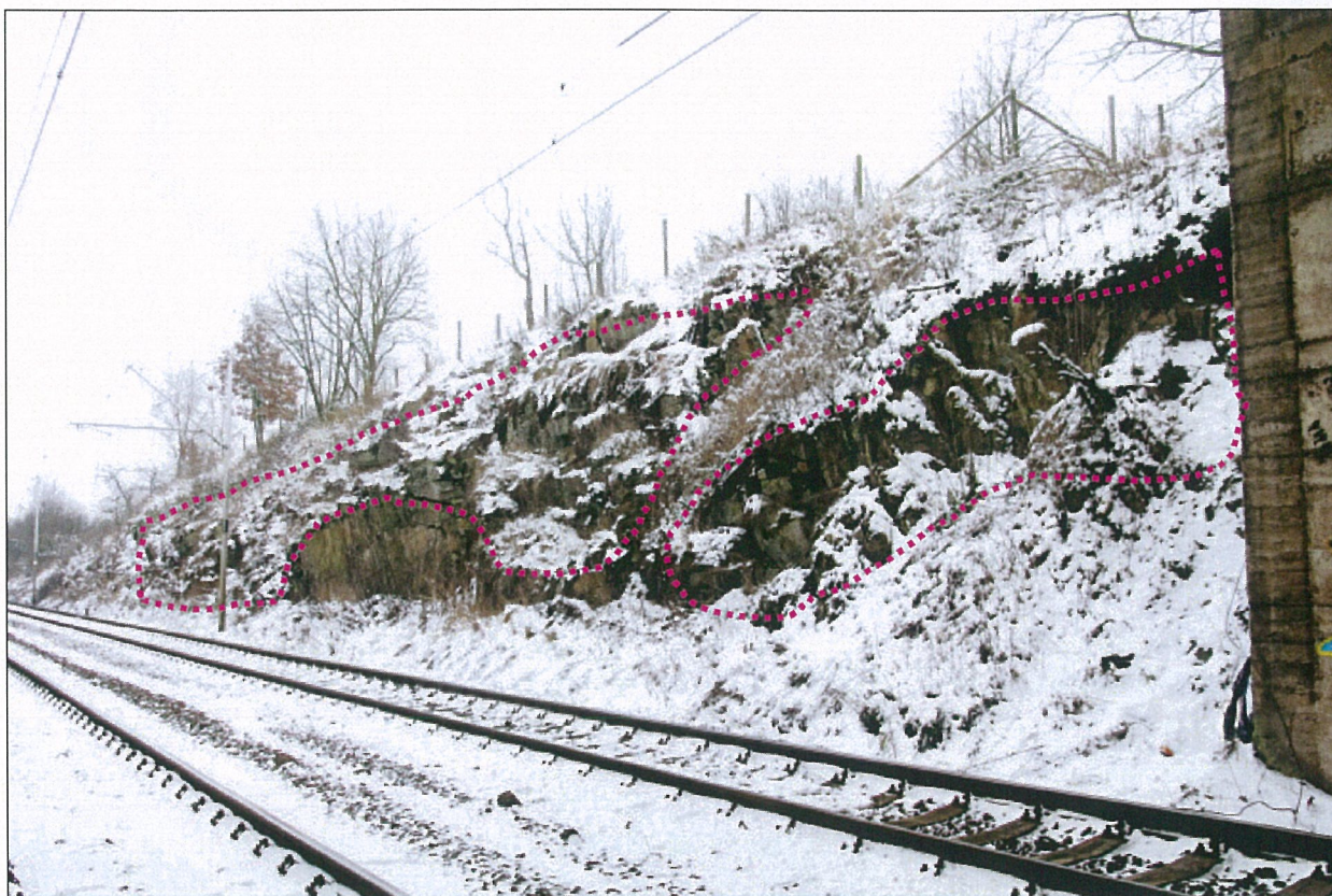
Foto – 15 Pohled na levou stranu k Horažďovicím od mostu. Jsou karmínově vymezené oblasti zcela rozvolněné horniny v líci. Bloky jsou ve stavu labilní rovnováhy.
