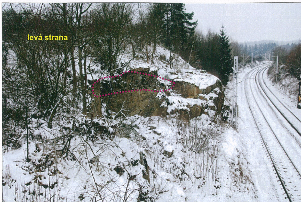
Foto – 21 Pohled z mostu na levou stranu svahu k žst. Pačejov s rozvolněnými bloky (vyznačeno jako karmínová oblast) v horní partii skalní stěny. U paty stěny se akumulují vypadlé fragmenty.
