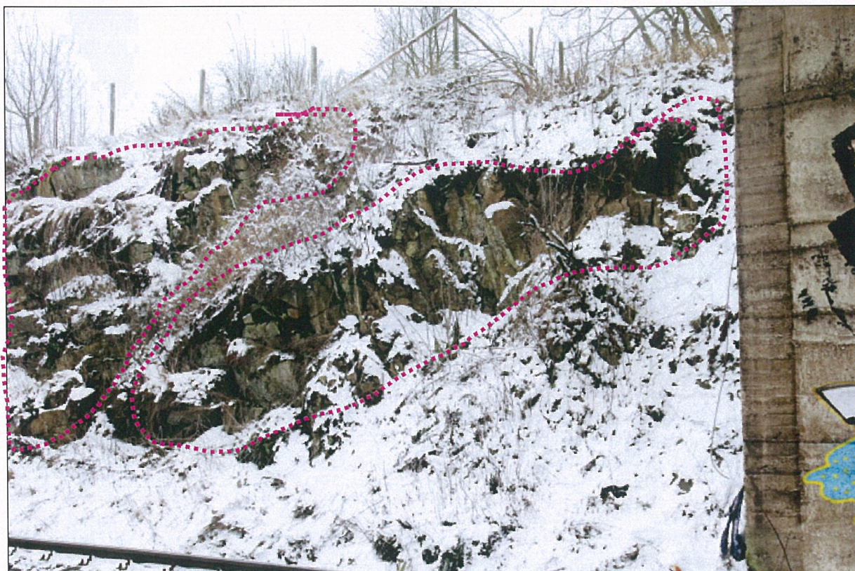
Foto – 14 Celkový pohled na rozvolněnou partii svahu v horní části na levé straně před mostem od Horažďovic. Karmínově jsou vyznačené problémové oblasti.
