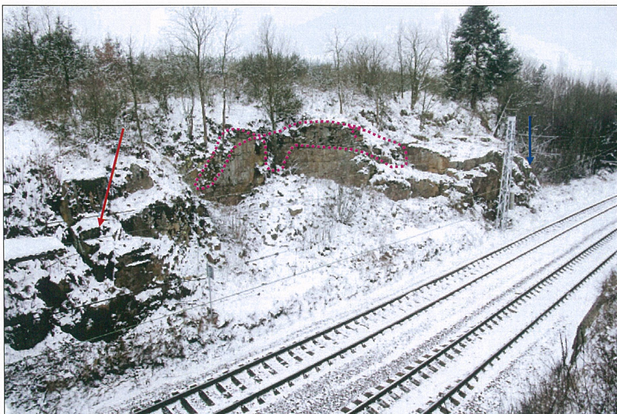
Foto – 4 Pohled z mostu směrem k Plzni na levý svah. Červená šipka ukazuje labilní blok horniny. Karmínově omezená oblast ukazuje na zcela rozvolněné partie svahu v horní části. Modrá šipka ukazuje na konec zajištění svahu na levé straně směrem k žst. Pačejov.
